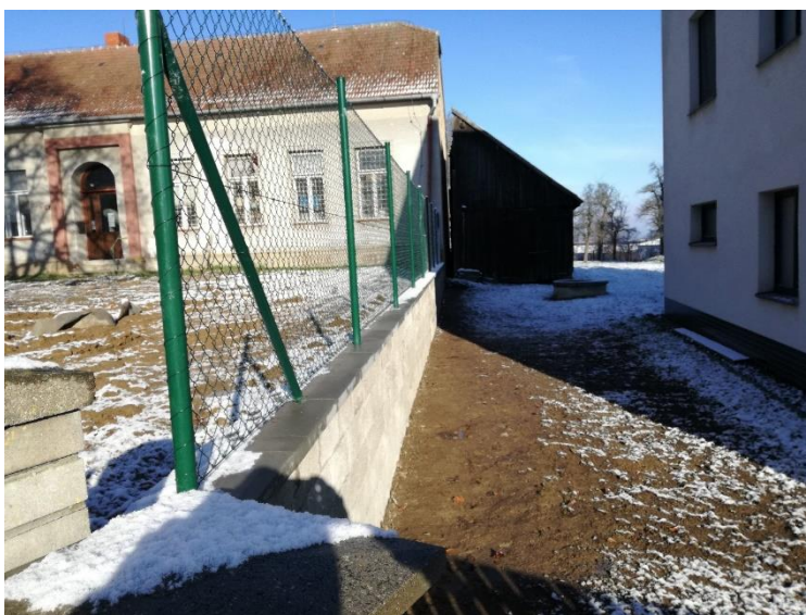
STAV PO OPRAVĚ
