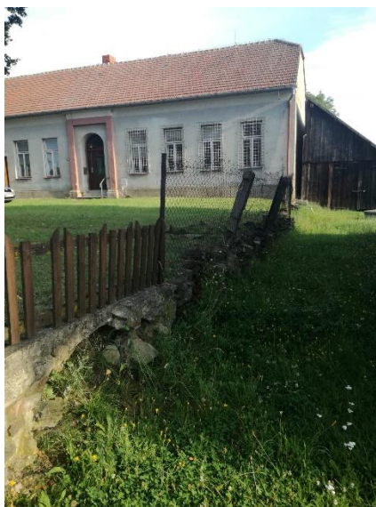
STAV PŘED REALIZACÍ OPRAVY
